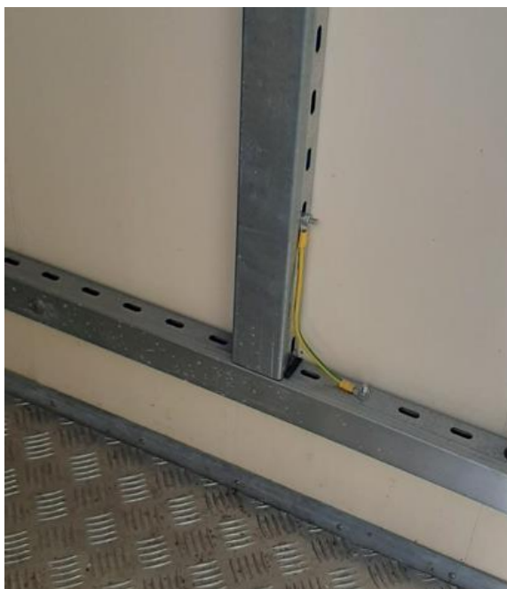
4 pav. Montavimo profilių įžeminimas
