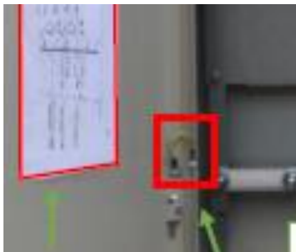
3 pav. Metalinės spintos durų įžeminimas
