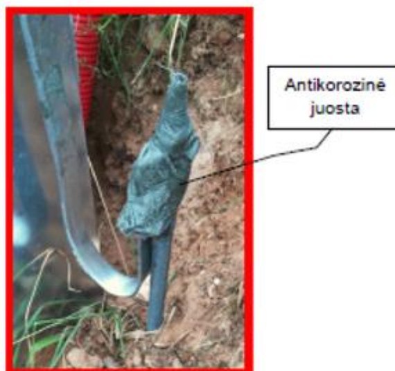
2 pav. Sujungimo vietos izoliavimas
