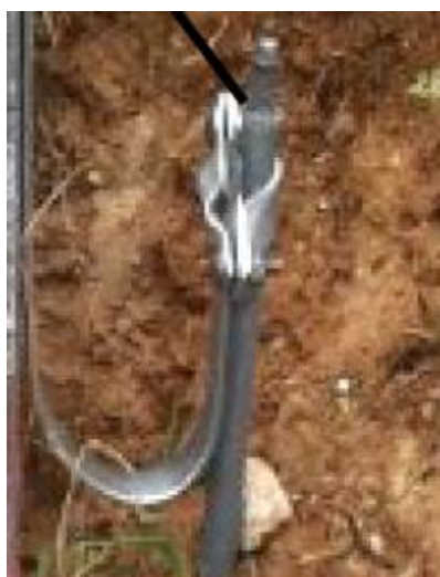
1 pav. Įžemintuvo ir įžeminimo laidininko sujungimas kryžmine jungtimi
