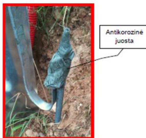
2 pav. Sujungimo vietos izoliavimas
