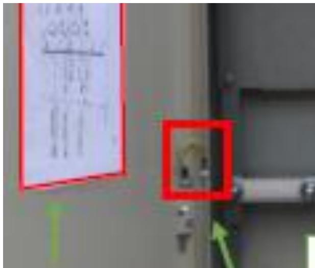
6 pav. Metalinės spintos durų įžeminimas
