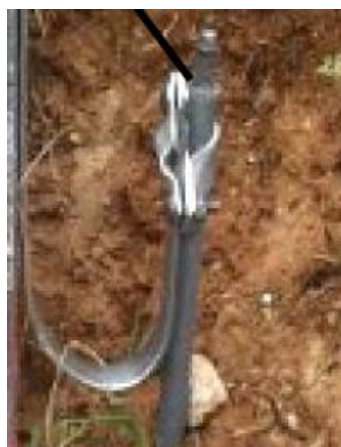
1, 1A pav. Įžemintuvo ir įžeminimo laidininko sujungimas kryžmine jungtimi
