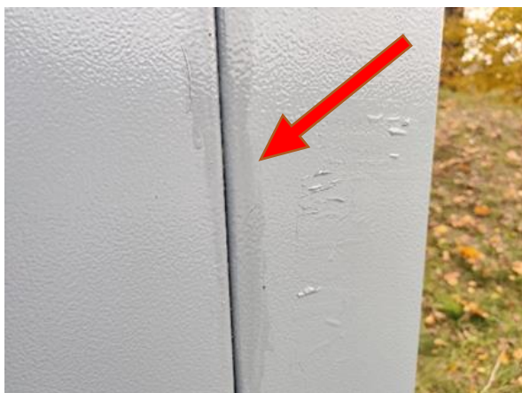
Blogai parinkta dažų spalva, pažeista darbų technologija
