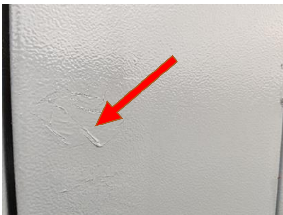
Dažai „susiraukšlėjo“, panaudotos netinkamos medžiagos
