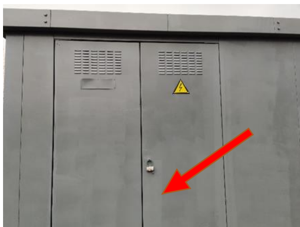
Paviršiai nudažyti netolygiai, panaudojant netinkamus darbo įrankius, su ryškiais perėjimais
