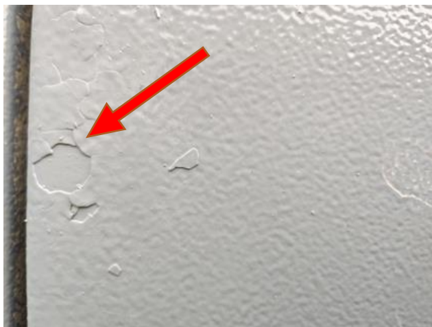
Nuo paviršių nenuvalyti esami atšokę dažai
