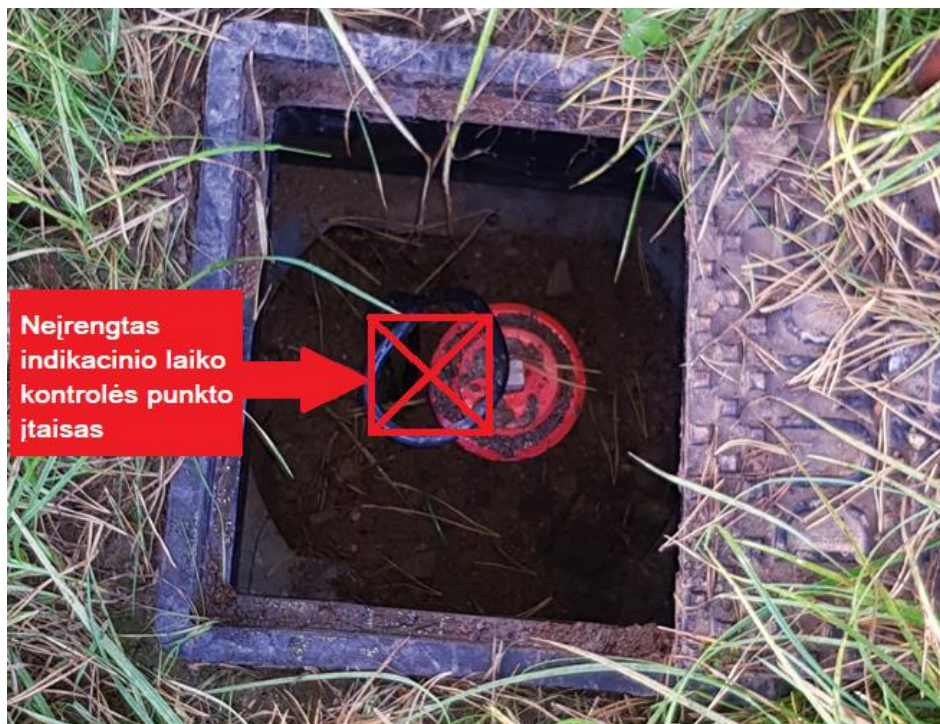
8 paveikslas. Netinkami indikacinio laido kontrolės punkto įtaiso įrengimo pavyzdžiai
