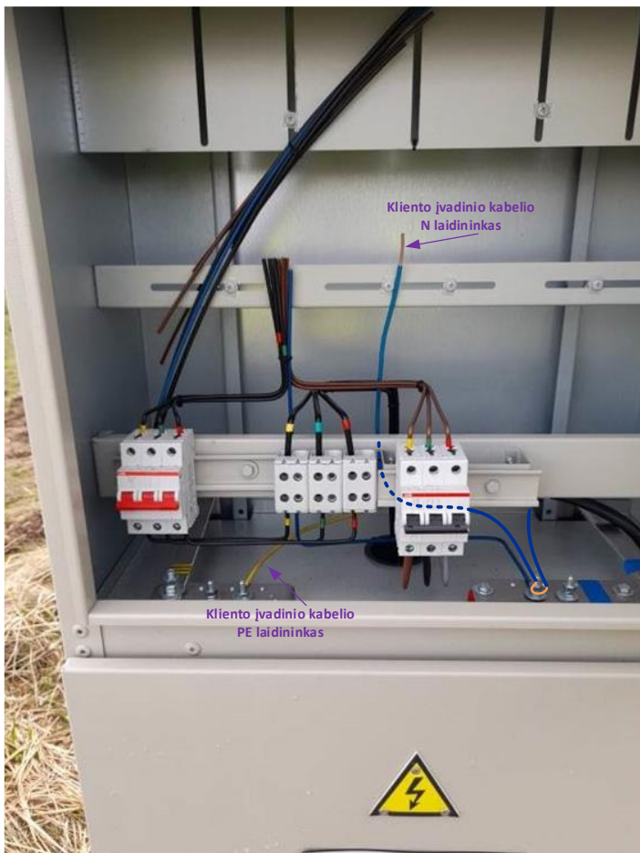
1 pav. Trifazio elektros skaitiklio pajungimo schemą, kai KAS montuojama tik PEN šina
