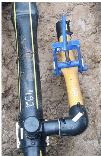
9 paveikslas. Užaklinto Apylankinio dujotiekio atvamzdis
