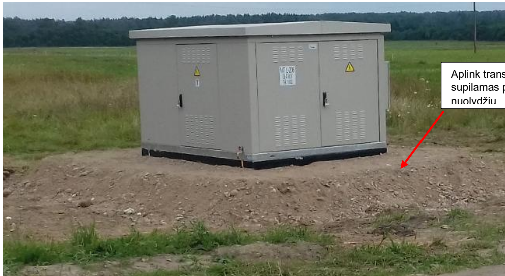
2 Pav. Žemės darbai įrengiamai transformatorinei (III-IV lygmens vietovėse arba užliejamose teritorijose).
